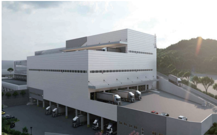
이천시 부발읍 신원리 물류창고 신축공사 34,697.82㎡ 지하2층~지상4층
