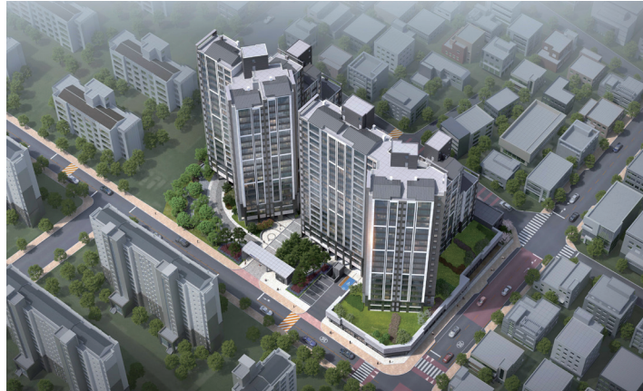
성창아파트 재건축정비사업 주택건설공사 30,352.13㎡ 200세대
