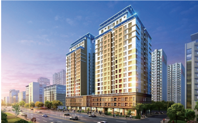
울산시 신정동 주상복합 신축공사 42,779.41㎡ 지하4층~지상20층
