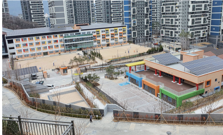
백봉초중 통합학교 신축공사 13,993.97㎡ 지하1층~지상4층
