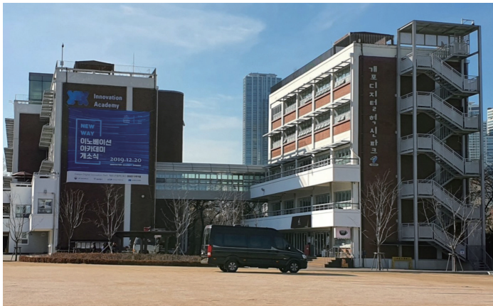
이노베이션 아카데미 교육시설 리모델링 공사 3,508.00㎡ 지하1층~지상5층
