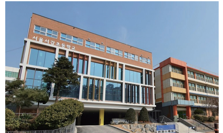
서강초등학교 증축공사 1,813.86㎡ 지상4층
