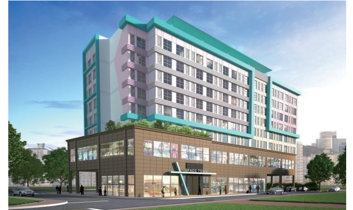
광양시 마동 도시형 생활주택 신축공사 6,854.89㎡ 158세대
